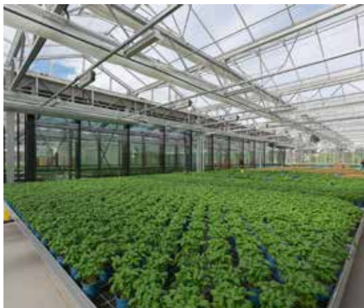
Die Bauweise des Gewächshauses ist modular aufgebaut und kann an anderer Stelle wieder aufgebaut werden.
